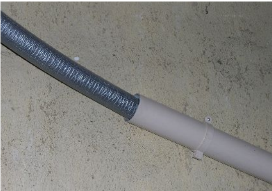
Supportage des tubes PER dans les combles
